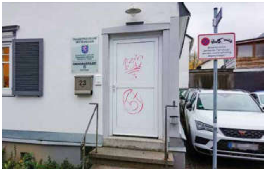
Graffiti an der Hauseingangstür des Polizeipostens Haiger: 1312 (=ACAB)
